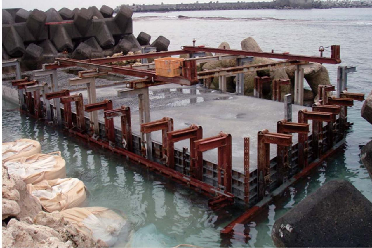
水中打設8.5m 1回打設 鹿児島県垂水市
